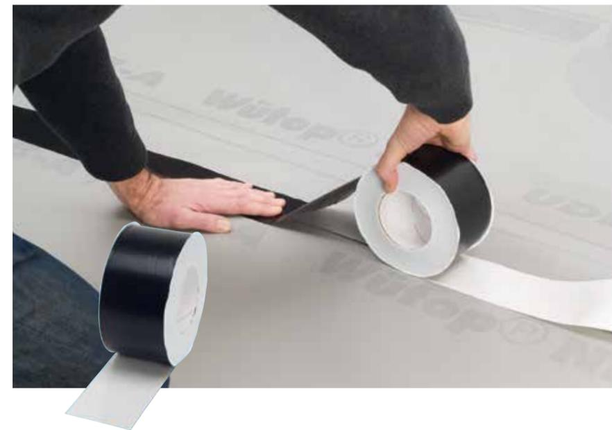
Bande adhésive extrêmement forte, pour collages imperméables à l'air et au vent de Wütop ND/SK.
